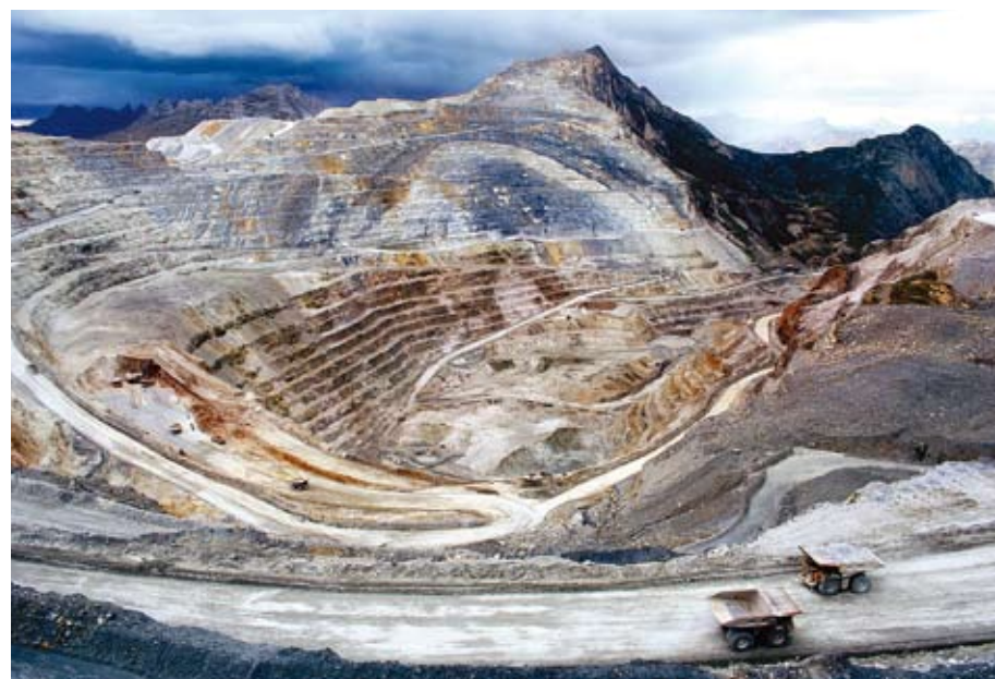
Mina a tajo abierto en Cajamarca.
